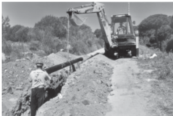
UNA MÀQUINA COLOCA UNA CANONADA PER A LA NOVA XARXA
